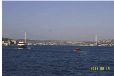
連結歐亞大陸的吊橋
